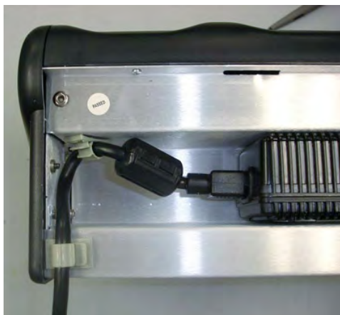
Attēls 59: Kabelis izvadīts caur plastmasas saspraudēm
