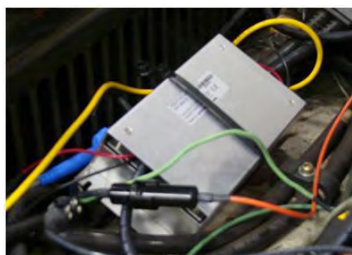
19 pav.: Prie tvirto paviršiaus pritvirtintas maitinimo blokas po prietaisų skydu
