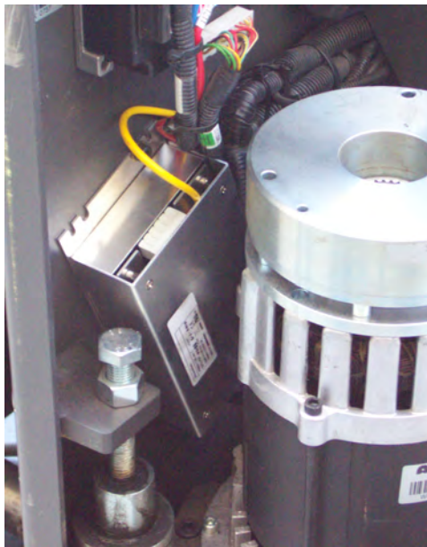
図 16 : ダッシュボードの下にある安全な場所に取り付けられた電源
