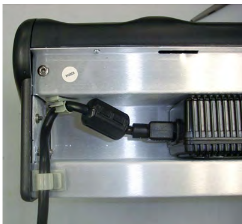
Illustration 19: Cheminement du câble par les attaches en plastique
