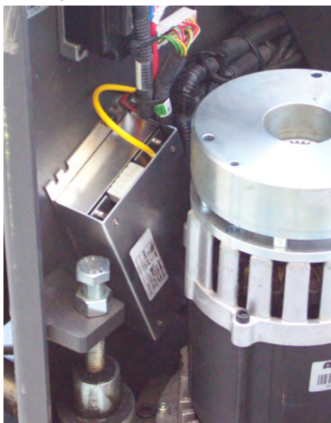
Figura 16: Suministro eléctrico fijado a una superficie segura debajo de un tablero de instrumentos
