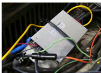
Obrázek 37: Zdroj napájení připojený k bezpečné ploše pod deskou
