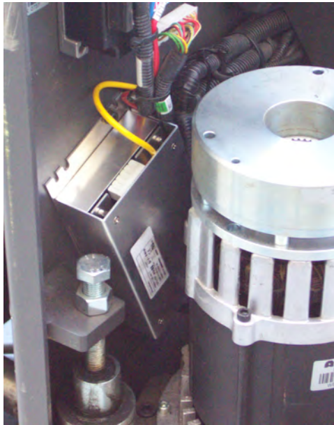
圖 17: 固定在倉庫車穩固表面上的電源供應器
